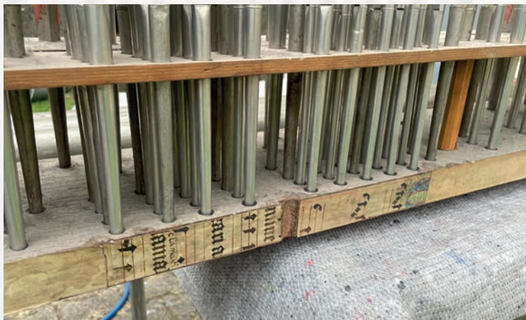
Die Pfeifen des Hauptwerks beim Putzen vor der Kirche. Gut zu erkennen sind die unterschiedlich alten Zinnlegierungen (1821 und 1974) und die historischen Seiten eines Hymnariums, die vor 200 Jahren auf die Stöcke aufgeleimt wurde.
